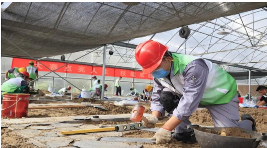
图 5-11 实践中心施工场所
